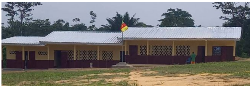
▲ Le centre scolaire de Diwon avec deux salles de classes, sanitaires filles et garçons, bureau du directeur.
