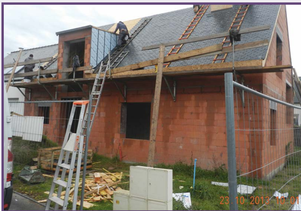
Les débuts du chantier en 2013.
