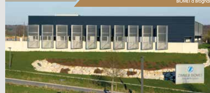
Immeuble mixte atelier/tertiaire construit pour l'entreprise ZIMMER BIOMET à Brognard
